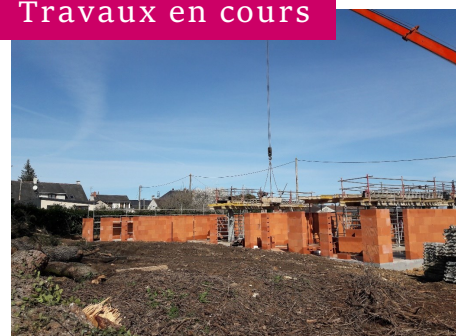
Construction de la structure AGE ET VIE
