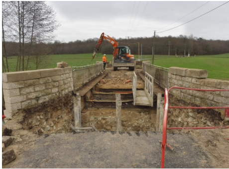
Réfection du Pont de Vaugedin
